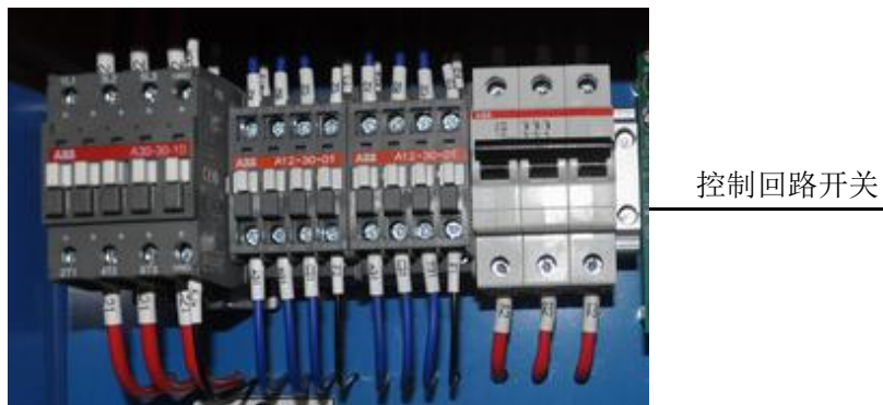
图 6 电源主回路控制开关
